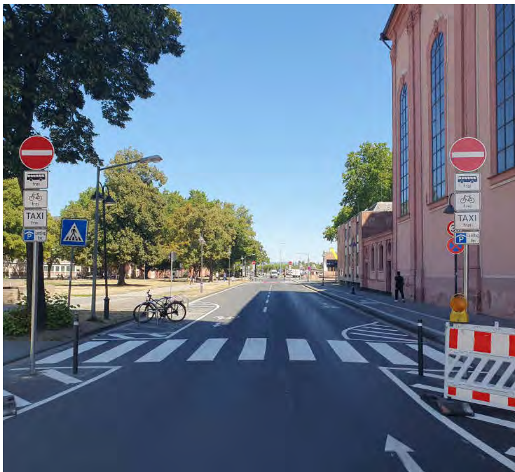
Große Bleiche Radweg-Abschnitt sorgt bislang für Verwirrung und mehr Stau in der Kaiserstraße.
