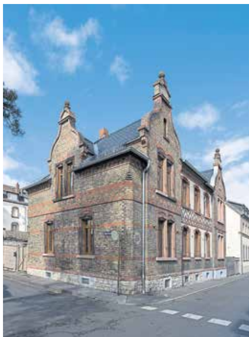
Das Haus hat schon kein Gerüst mehr, die Sanierung ist fast abgeschlossen
