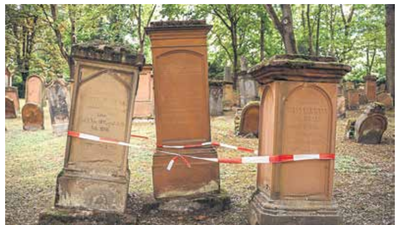
Baustelle der Zukunft: Gefährdete Grabsteine
