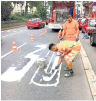
Zwei Arbeiter schwingen die Pinsel
