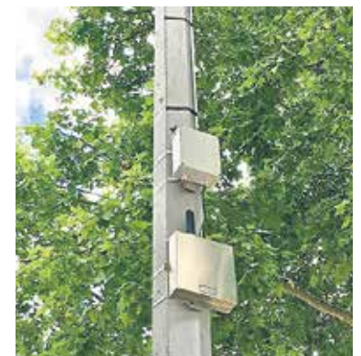
Sensoren und Kameras messen Luftschadstoffe und Verkehr
