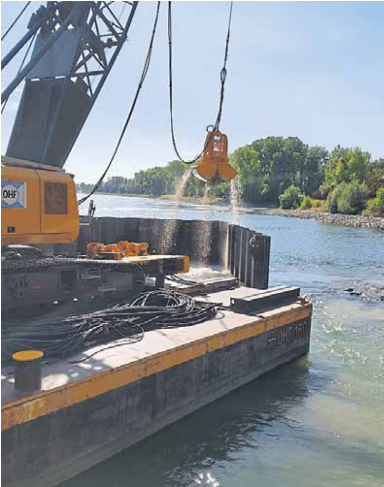
Die drei Tonnen schwere Baggerschaufel kommt gefüllt mit vier Tonnen Kies aus dem Wasser
