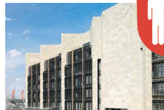
Das Rathaus muss teuer saniert werden ...
