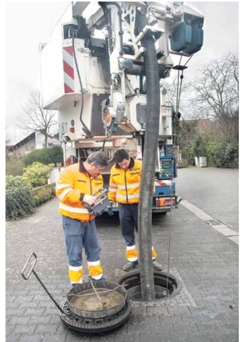
Durch den Kanaldeckel werden die Rohre gereinigt
