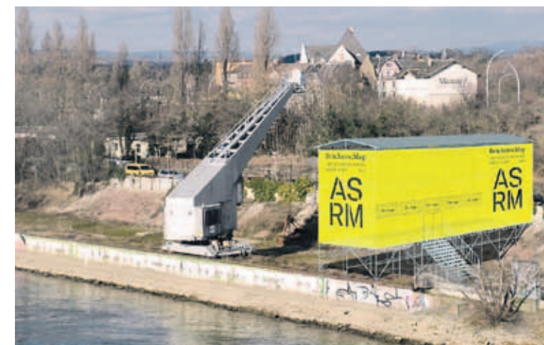
Architektursommer-Pavillon mit Kultur-Events am Kasteler Ufer
