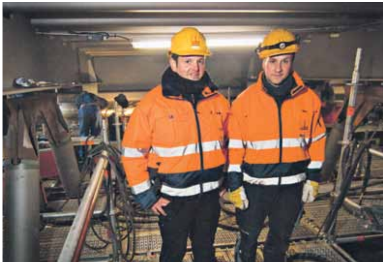
Nachtbaustelle Schiersteiner Brücke - Patrik Türk und Christian Lindner kontrollieren die Schweißnähte
