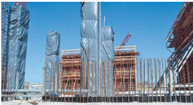
Der Grundstein ist gelegt. Ab Ende 2013 sollen von hier aus 12.000 Einfamilienhäuser mit umweltfreundlicher Energie versorgt werden
